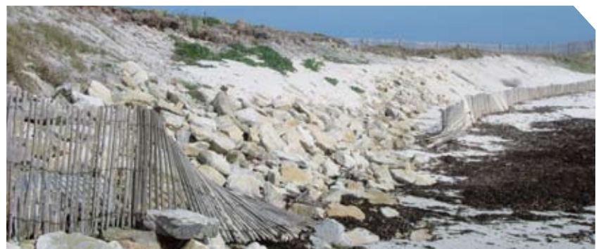
Les ganivelles au premier plan n'ont pas résisté aux tempêtes.
